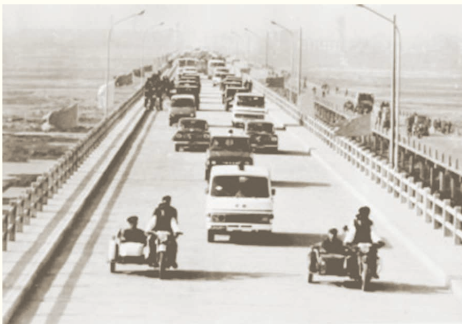
1983年12月，紧挨低桥建设的金雀山路沂河公路大桥通车
