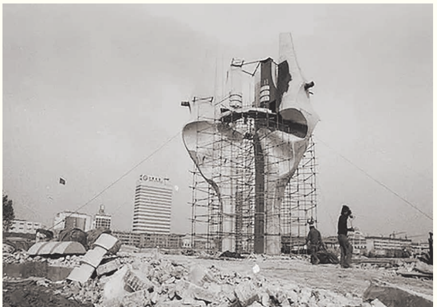
广场雕塑“山高水长”在建设中
