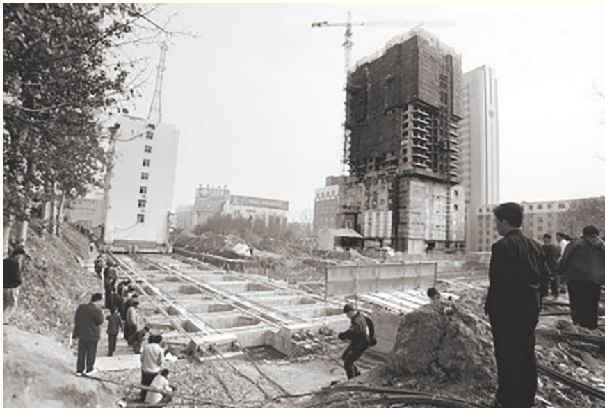
广场东南角国安大厦平移
