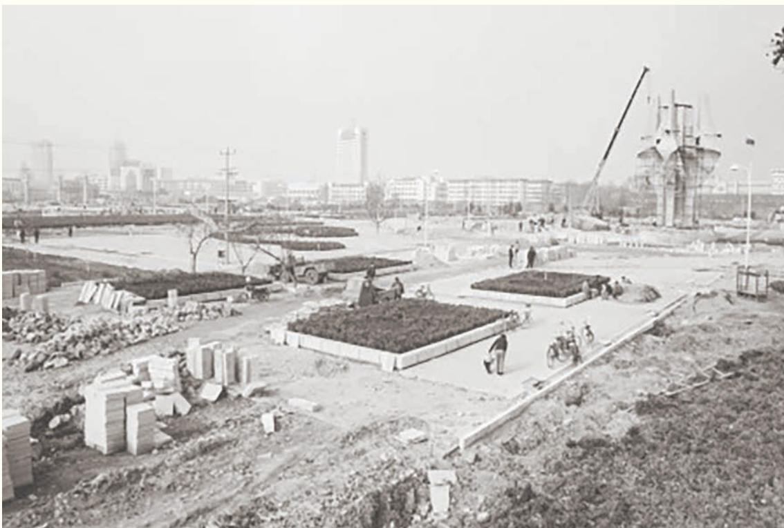
建设中的人民广场全景
